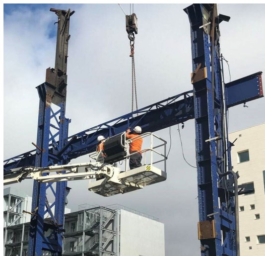
Récupération des poutres des Halles Alstom
